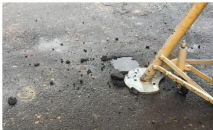
Uno de los rayos cayó cerca de Coopesa y otros dos en el área de los puentes de abordaje.
